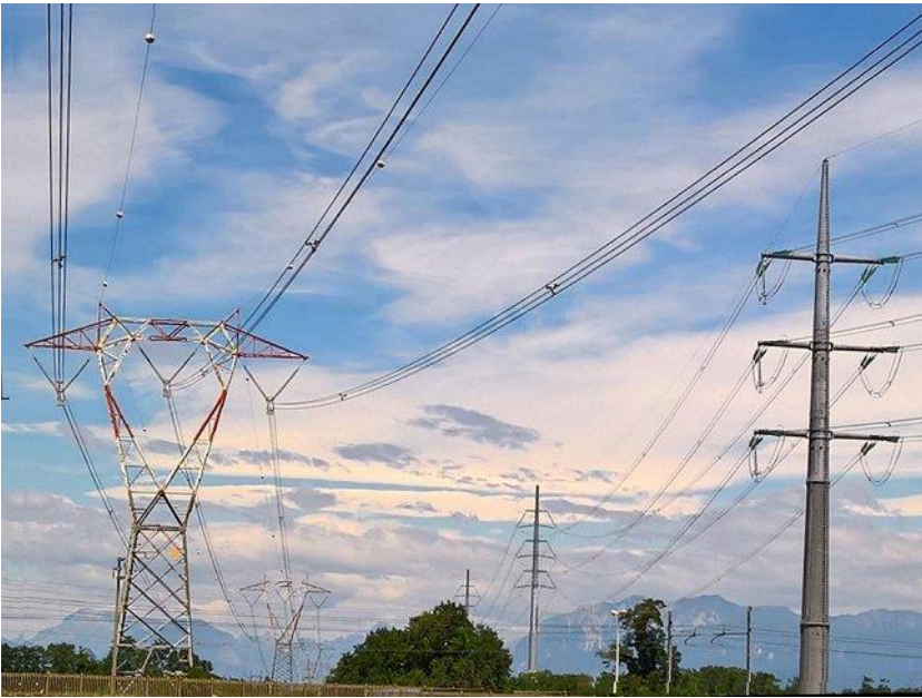
Linee a 380 kV italiane con i nuovi tralicci monostelo e quelli del vecchio tipo.
