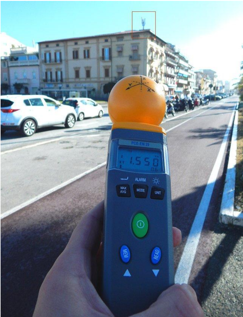
Misurazione del campo di una seconda stazione radio base sul tetto (1,5 V/m).
